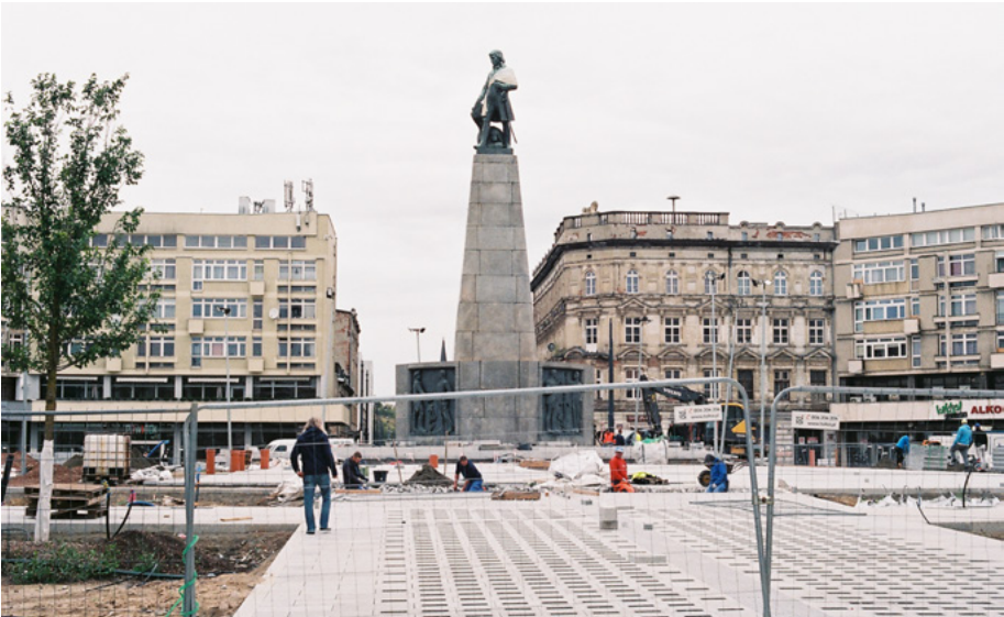
Plac Wolności under repair at the top of Ulica Piotrkowska.
